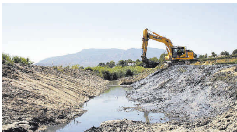
Obras de la CHS en la rambla de Agua Amarga en Cieza, que se desbordó por varios puntos en la dana de octubre.
